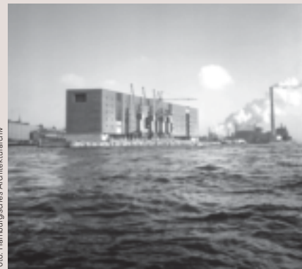
Der Kaispeicher A, 1966
