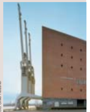
Der Kaispeicher A, 2006
