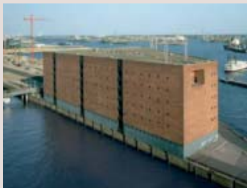
Der Kaispeicher A, 2006
