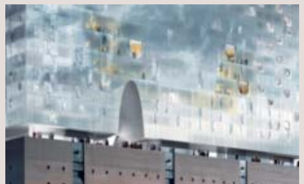
Ausschnitt der Fassade von Nordosten gesehen
